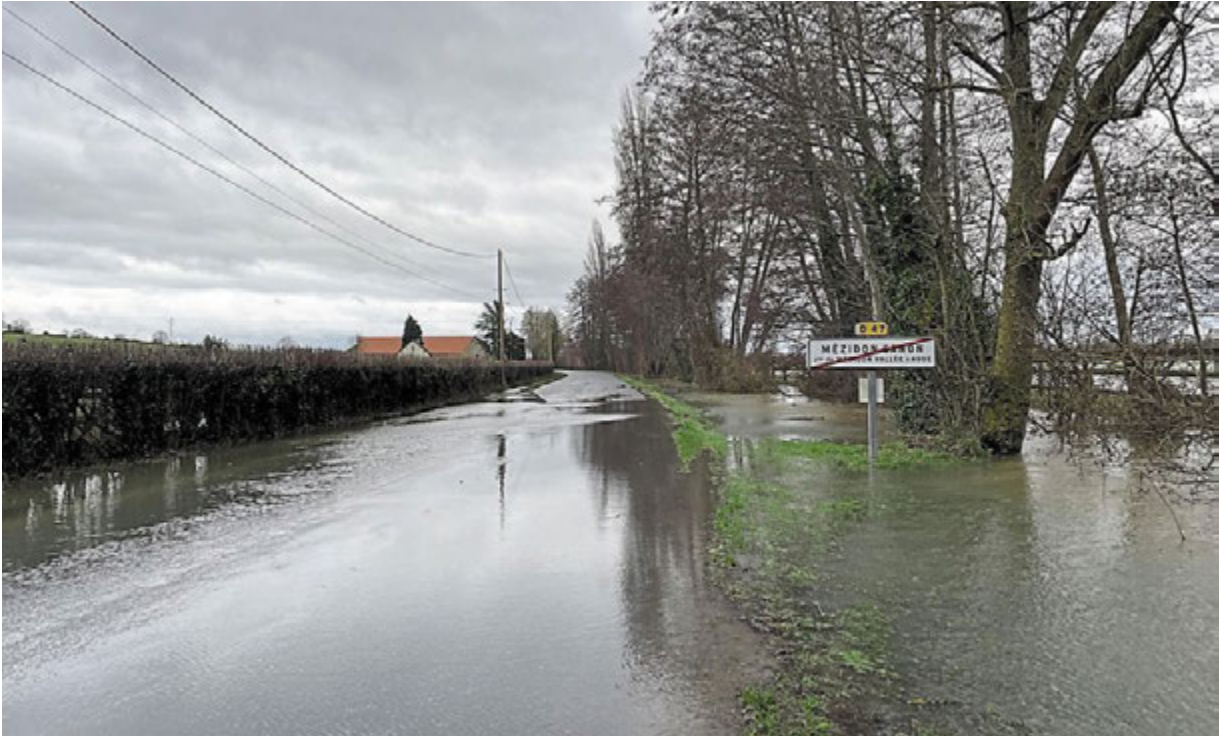
Débordement de la Dives, à l’entrée de Mézidon-Canon, rue Roger-Salengro, dimanche 26 janvier.
