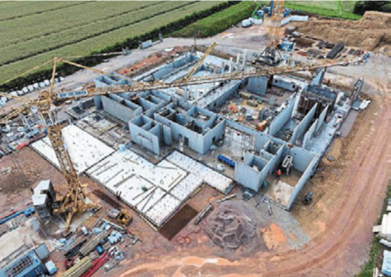
Vue aérienne du chantier du centre aquatique de Saint-Pierre-en-Auge, en juin dernier.
